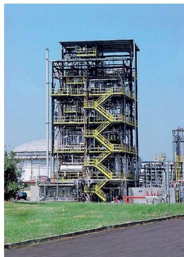
Une installation pilote Fischer-Tropsch (capacité de 20 barils de carburant par jour) fonctionne à la raffinerie de Sannazaro de Burgondi en Italie dans le cadre d'un projet conjoint entre l'IFP, Axens et le pétrolier italien ENI.
