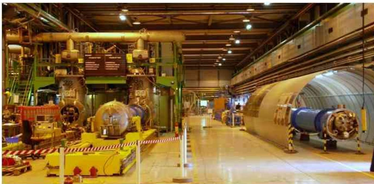
Suite à une question, il est précisé que le tunnel est creusé dans une couche de marne particulièrement stable, couche associée au Jura voisin. L'ensemble est solidement arrimé, de sorte qu'en cas de tremblement de terre, tout bouge de façon solidaire et minimise les risques.
